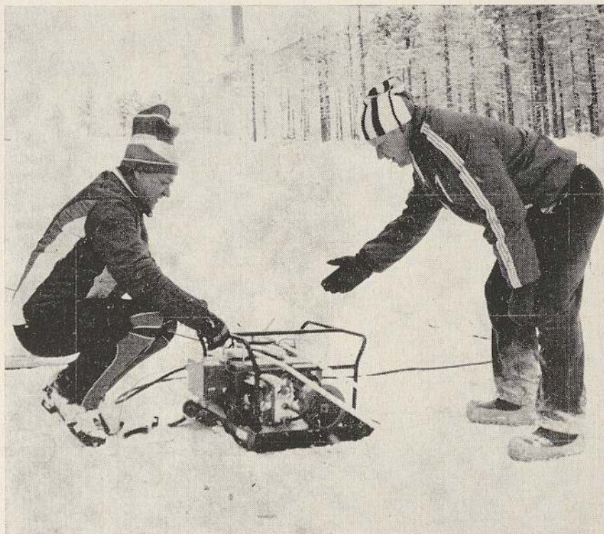
Instalace pohonné jednotky přenosného lyžařského vleku MEZ na Lysé hoře v Beskydách. Zleva Pavel Veverka a projektant vleku Ing. Jan Šrubař
