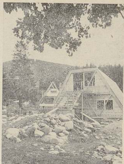
Tak vypadala výstavba dolní stanice lanovky začátkem října
