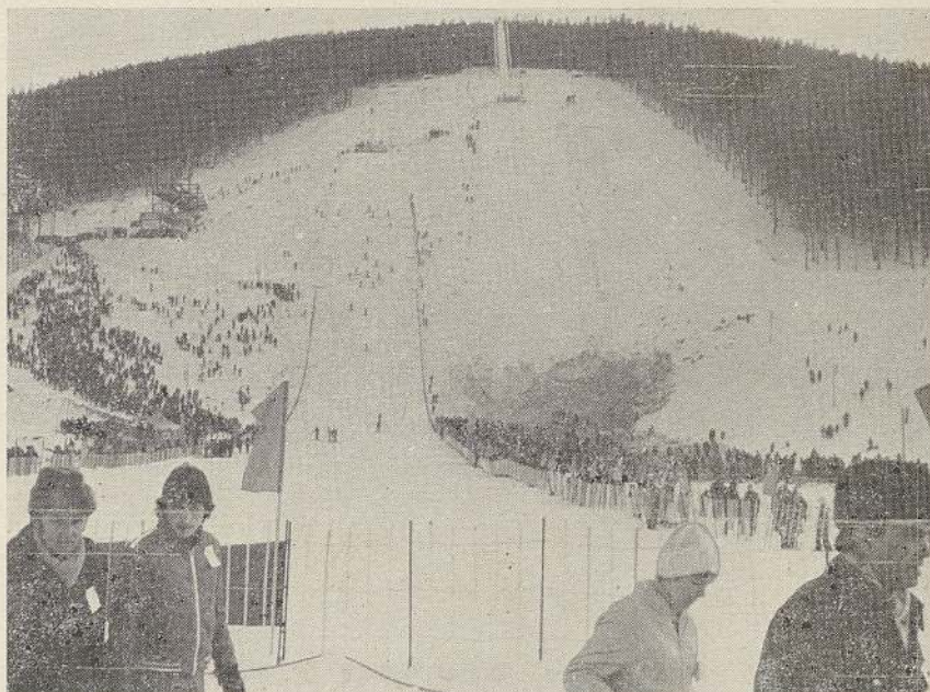
Pohled na skokanský areál v Harrachově. Vlevo mamutí můstek, který bude dějištěm mistrovství světa 1983 v letech, vpravo velký můstek s normovým bodem 90 m
