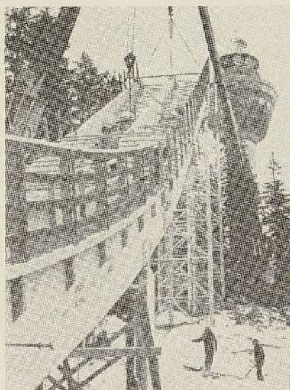
Výstavba nového můstku na lyžařském stadiónu Puijo, který bude dokončen před zahájením nové sezóny
