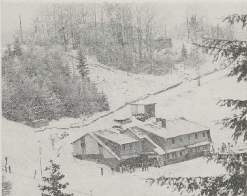
Hlavním objektem areálu sjezdového lyžování Soláň je chata Soláňka, jejíž výstavba byla dokončena loni a úspěšně zakončena kolaudací
