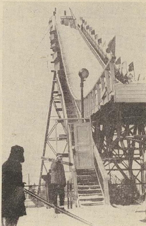
Chloubka lyžařů SSSR — lyžařská zařízení v Kovgolovu. Na snímku nájezdová věž kovgolovského můstku.
