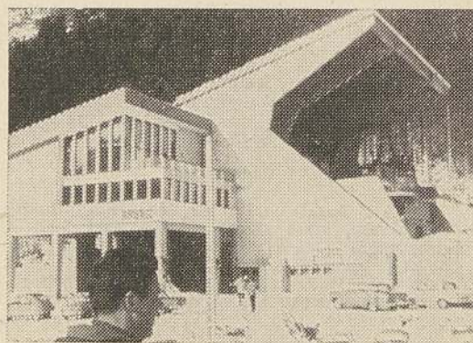
Stanice lanovky Avoriaz (obr. č. 3)
