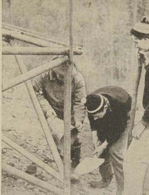
■ Snímek patří minulosti. Brigáda na dokončení malého můstku.
