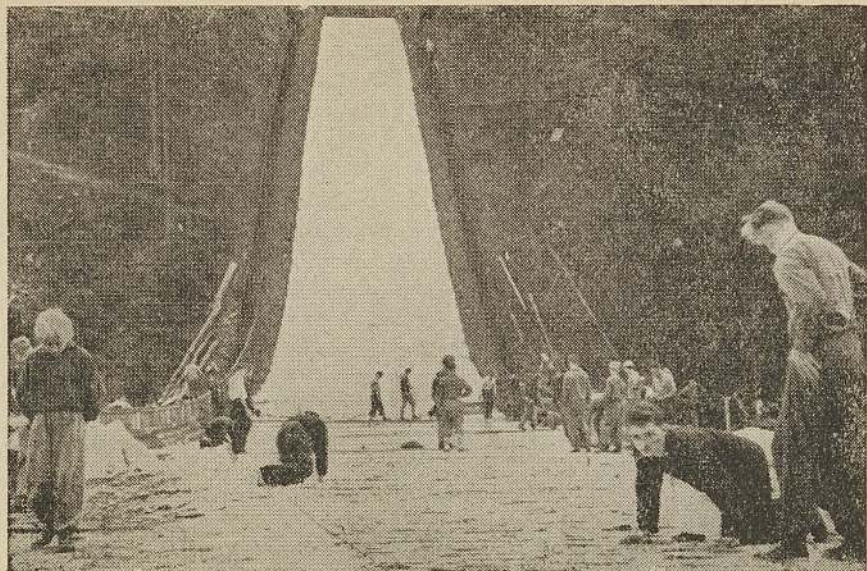
Malé rohože z hmoty PVC je nutno pořádně upevnit a utěsnit. Právě se pracuje na dojezdové ploše
