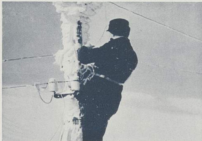
Odstraňování poruch na sloupech není rozhodně lehkým zaměstnáním. Foto Comercia-Film.
