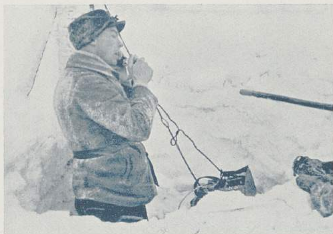
Zatím co čekáte v teplé boudě na spojení, musí Vám je montér zjednávat často hluboko pod sněhem.
